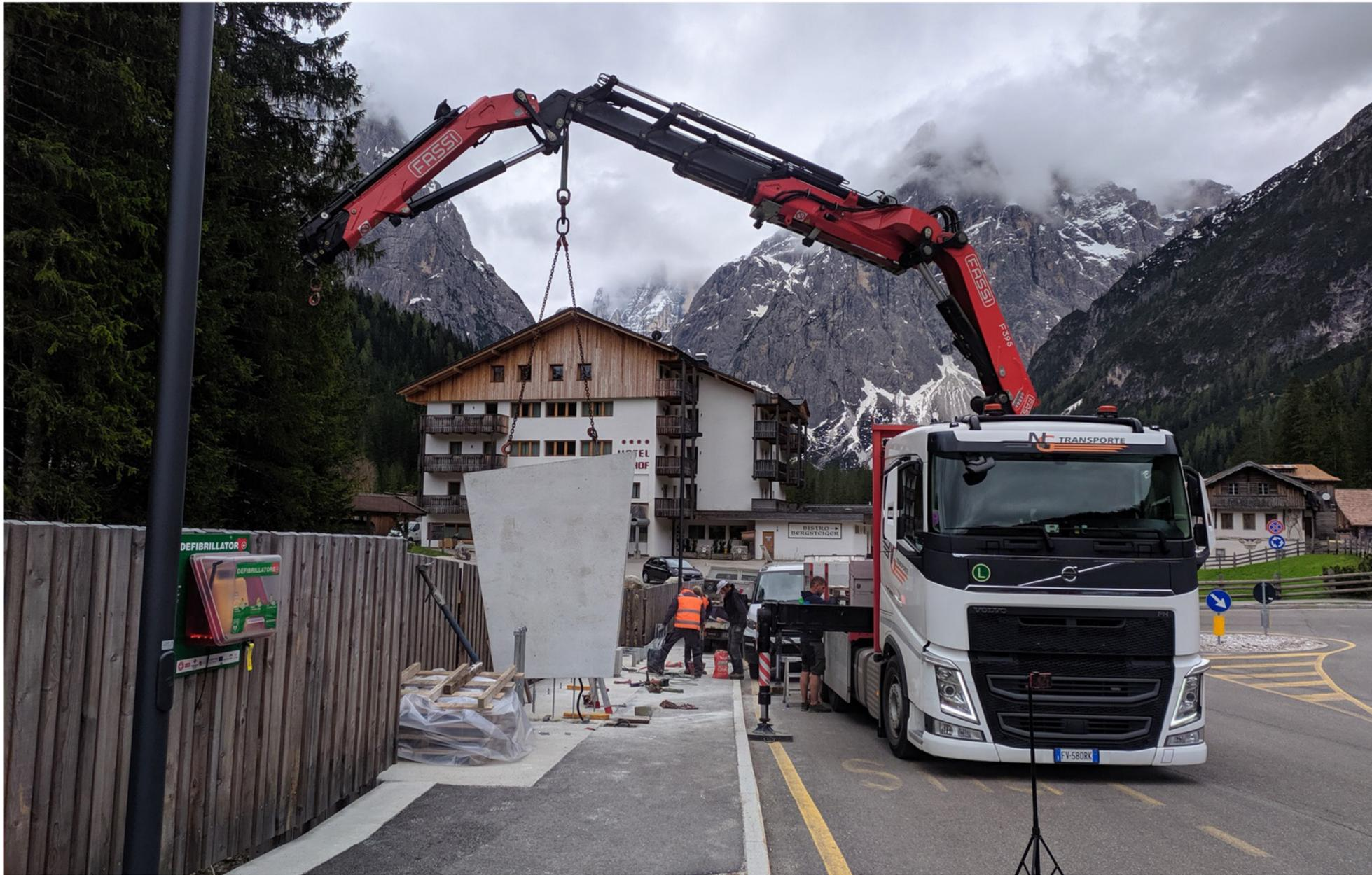
Fermata Val Fiscalina: posizionamento delle pareti laterali prefabbricate in cemento armato
