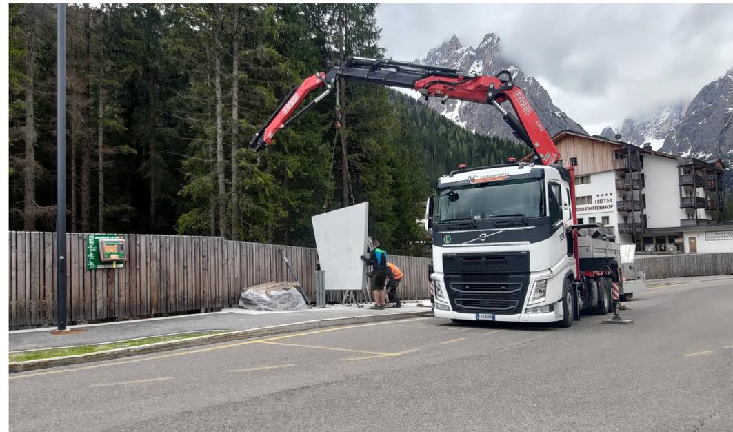
Fermata Val Fiscalina: posizionamento delle pareti laterali prefabbricate in cemento armato
