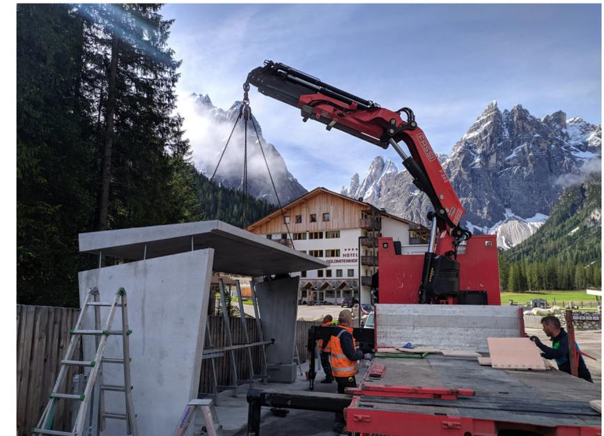
Fermata Val Fiscalina: posizionamento delle coperture prefabbricate in cemento armato
