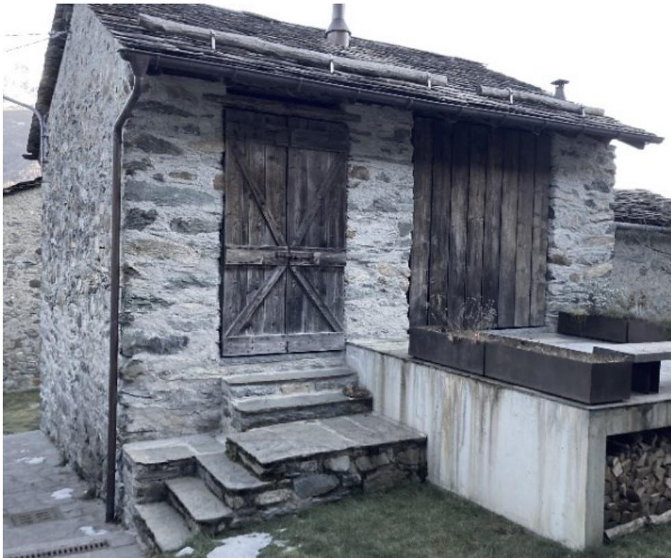
Le aperture verso l'esterno non sono state modificate, così come l'altezza del colmo e delle gronde ed ogni elemento in pietra originale di serpentino.
