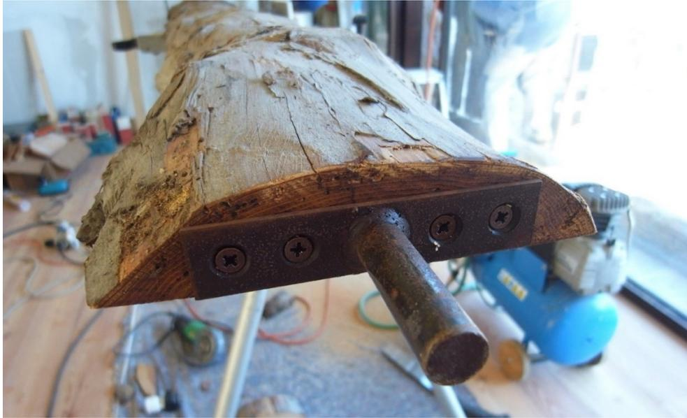
Il sistema è volutamente semplice e pensato per un uso manuale. Le assi sono state smontate, ad ognuna è stato avvitato un perno in acciaio corten alle due estremità e successivamente sono state riposizionate nei dormienti.
